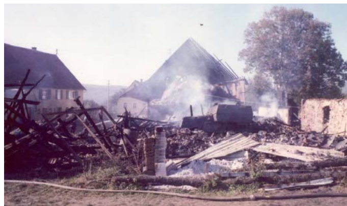
Bis auf die Grundmauern niedergebrannte Stallungen und Scheuer beim Großbrand auf dem Zahnberg am 13. Okt. 1984.
