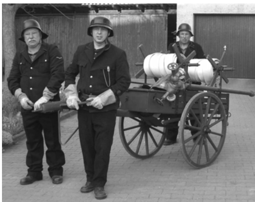
Der Löschkarren von 1898 zur Wasserentnahme aus einem Hydranten bei einer „historischen Übung“ 2011.
